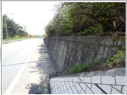
15 진출부 옹벽 전경
