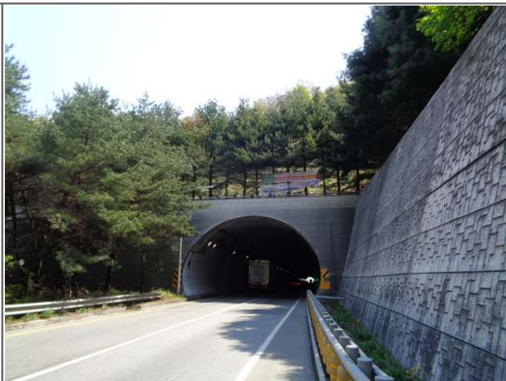
갭문 및 옹벽 전경
