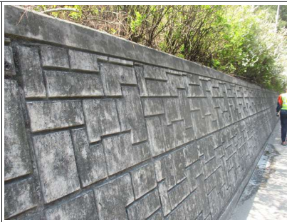
14 진출부 옹벽 전경
